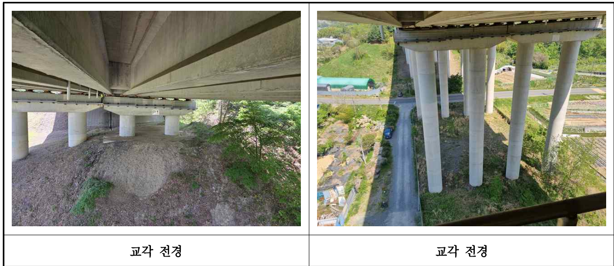
【사진 23.3.10】 교각 전경
