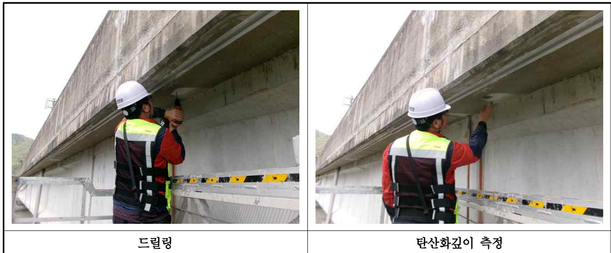
【사진 23.4.3】 탄산화 깊이 측정 현장사진
