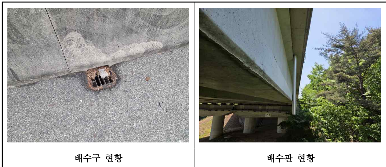
【사진 23.3.22】 배수시설 전경
