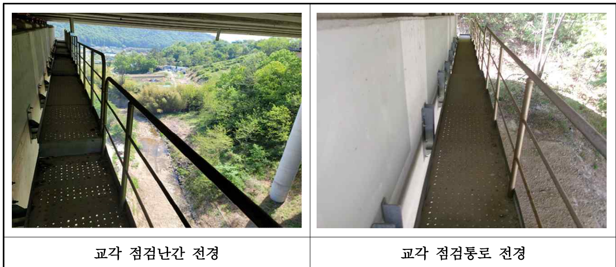
【사진 23.3.26】 교량 점검시설 전경
