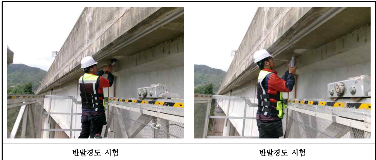
【사진 23.4.2】 반발경도시험 현장사진
