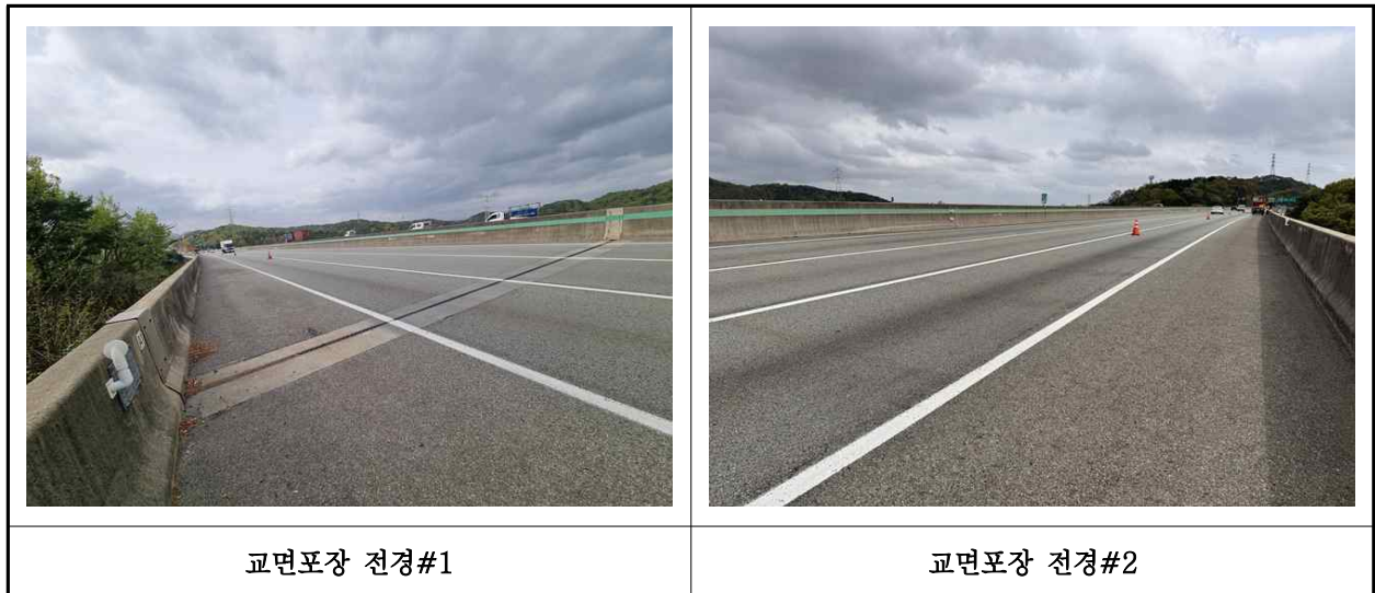
【사진 23.3.20】 교면포장 전경
