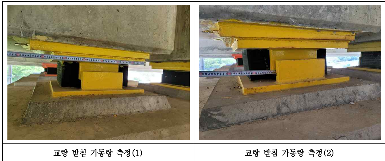
【사진 23.3.16】 교량받침 이동량 측정
