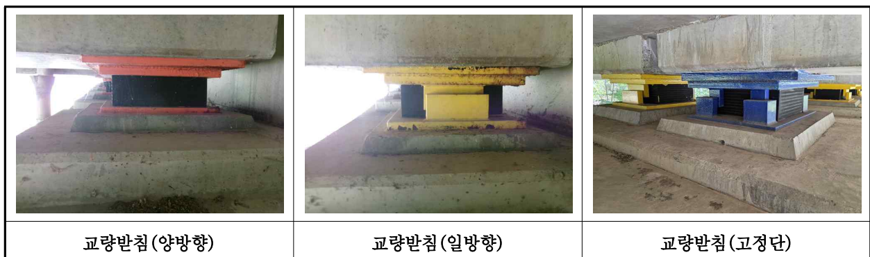
【사진 23.3.13】 교량반침 전경
