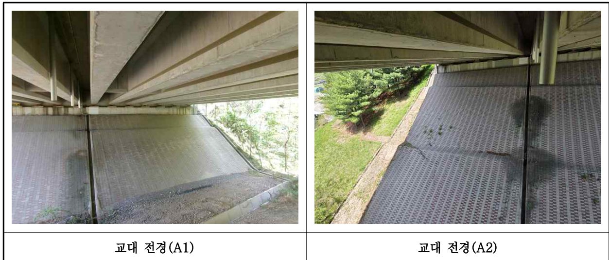
【사진 23.3.8】 교대 전경
