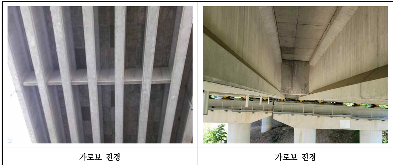
【사진 23.3.6】 가로보 전경
