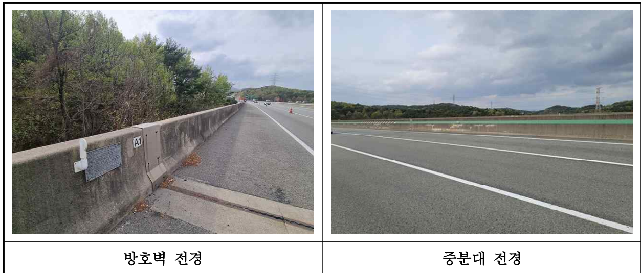
【사진 23.3.24】 방호벽 및 중분대 전경
